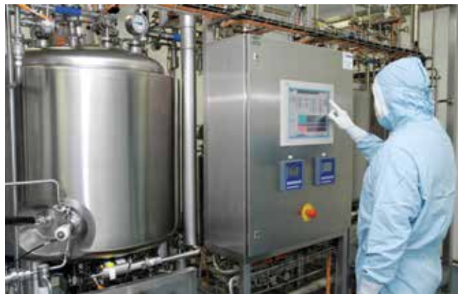
Реакторный участок цеха по производству генно-инженерного инсулина человека
